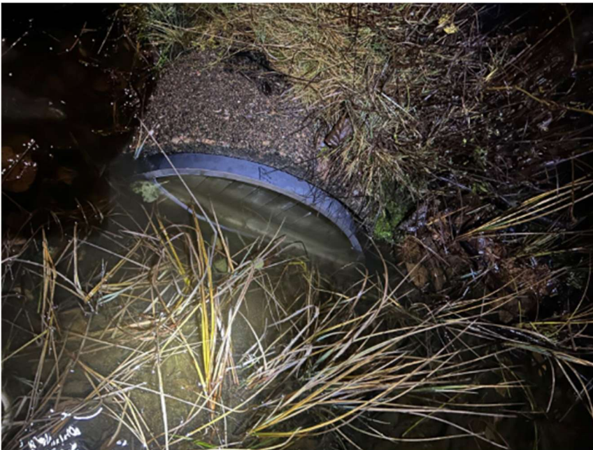
Kuva 6. Rivieran rannan lampien väliseen putkeen asennetut päätykannet. (Almi, T. 2025)
