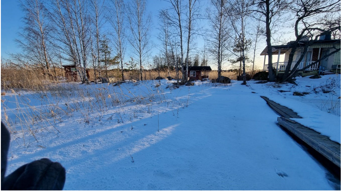
Kuva 2-12. Kiinteistön 51 rakennukset. Kuvattu keväällä 2023.
